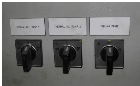
Εικόνα 23: Οι διακόπτες ρύθμισης λειτουργίας των αντλιών κυκλοφορίας θερμαντικού ελαίου.
