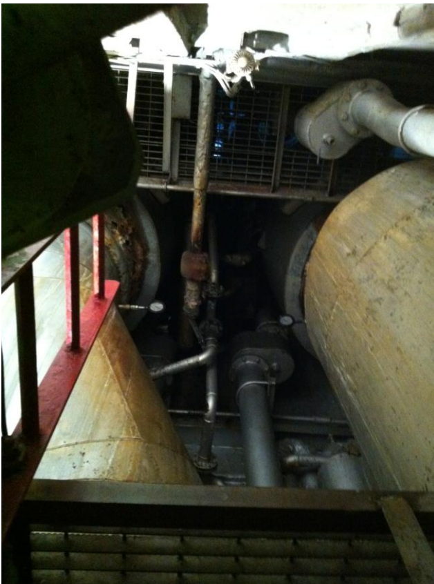
Εικόνα 17: Η περιοχή στο κατώτερο επίπεδο από την εστία της πυρκαγιάς και στον χώρο των οικονομητήρων Νο 2 και 3.
