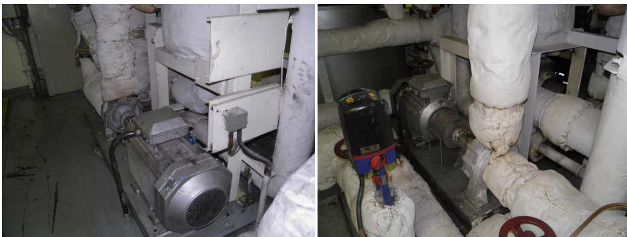
Εικόνα 24: Οι αντλίες κυκλοφορίας θερμαντικού ελαίου No. 1 και 2
