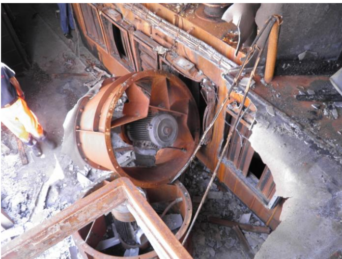
Εικόνες 10 και 11: Κατάρρευση του αλουμινένιου δαπέδου στήριξης των εξαεριστήρων στο άνω τμήμα της καπνοδόχου.
