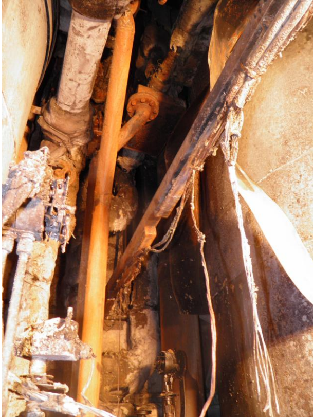
Εικόνες 5 και 6: Επιρροές από την πυρκαγιά στον χώρο της εστίας. Παρατηρείται κυρίως καύση των μονώσεων και οξείδωση των μεταλλικών επιφανειών
