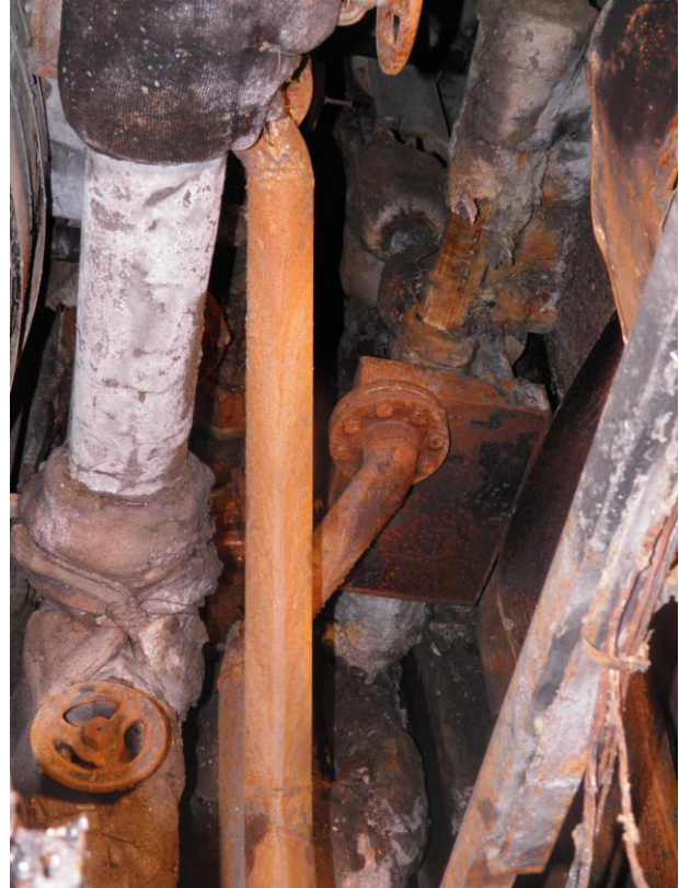
Εικόνες 5 και 6: Επιρροές από την πυρκαγιά στον χώρο της εστίας. Παρατηρείται κυρίως καύση των μονώσεων και οξείδωση των μεταλλικών επιφανειών
