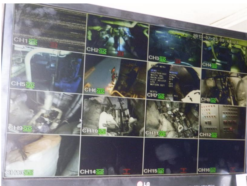
Εικόνα 35: Εικόνα από το κλειστό κύκλωμα καμερών για την παρακολούθηση του χώρου των οικονομητήρων από το ECR.
