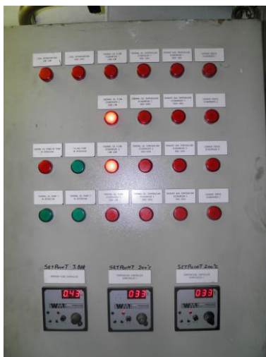
Εικόνα 2: Ο ηλεκτρικός πίνακας των αντλιών κυκλοφορίας θερμαντικού ελαίου και οι διακόπτες τροφοδοσίας ηλεκτρικού ρεύματος.
