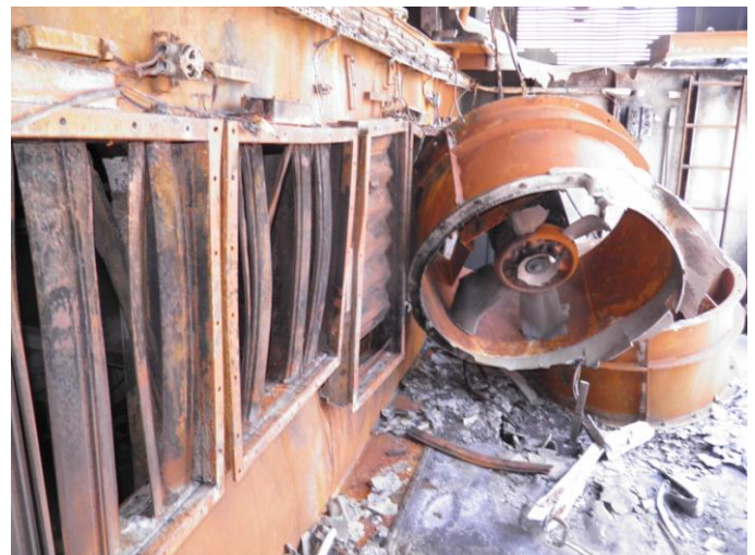
Εικόνες 10 και 11: Κατάρρευση του αλουμινένιου δαπέδου στήριξης των εξαεριστήρων στο άνω τμήμα της καπνοδόχου.
