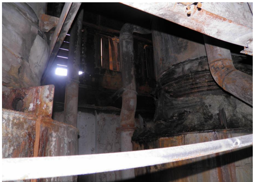
Εικόνες 5 και 6: Επιρροές από την πυρκαγιά στον χώρο της εστίας. Παρατηρείται κυρίως καύση των μονώσεων και οξείδωση των μεταλλικών επιφανειών
